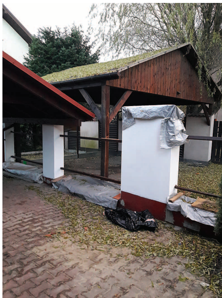
Prace remontowe w toku
