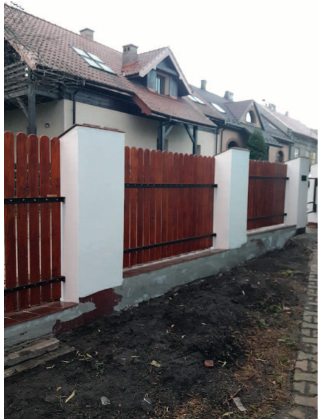
Widok od strony południowej
