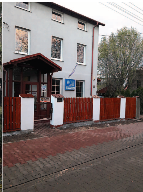
Odnowione ogrodzenie – widok od frontu
