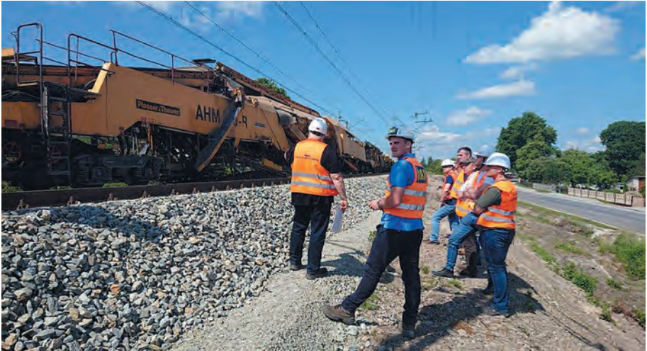
Pokaz pracy pociągu do wymiany podtorza AHM
