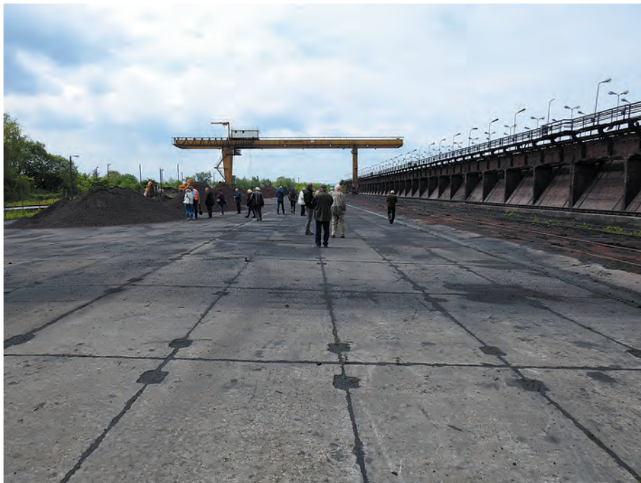
Jedna z estakad do przeładunku rudy żelaza na stacji Hurko – Medyka
