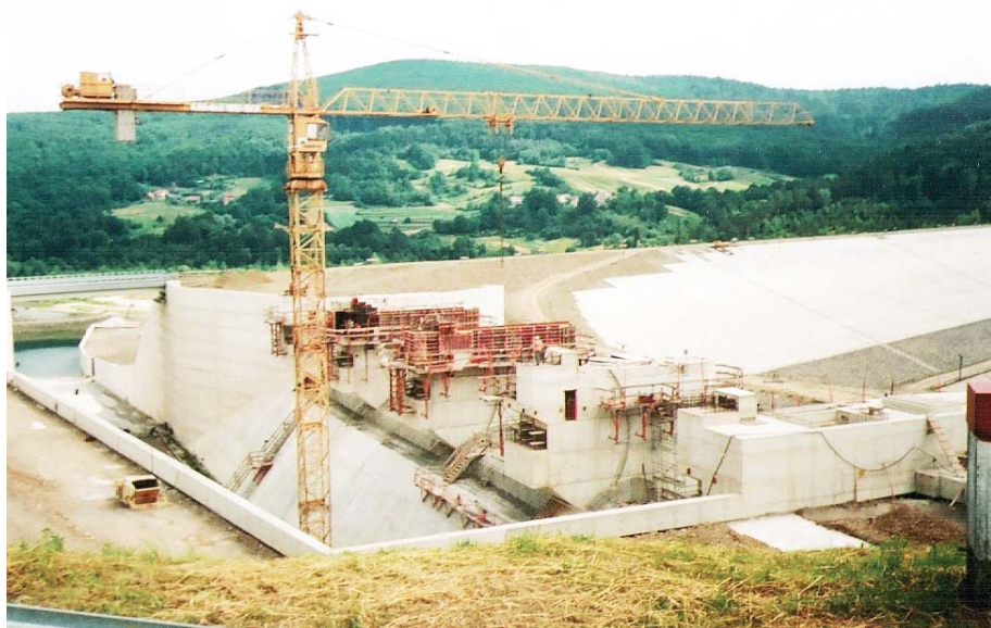
Teren budowy zapory w Świnnej Porębie
