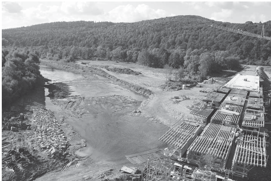
Widok z pylonu na budowę z mostu na rzece Skawa w Zembrzycach
