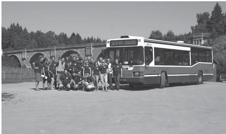
Wiadukt kolejowy w Stańczykach
