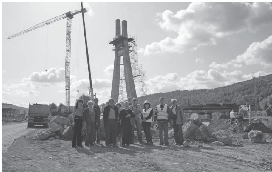
Plac budowy w Zembrzycach – w tle pylon budowanego mostu
