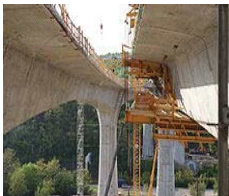
Budowa mostu nad rzeką Wełtawą na obwodnicy Pragi
