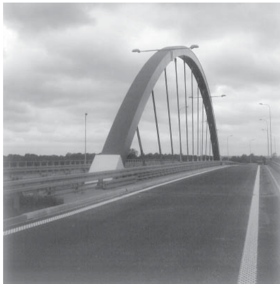
Wiadukt budowany w ciągu drogi ekspresowej S3
