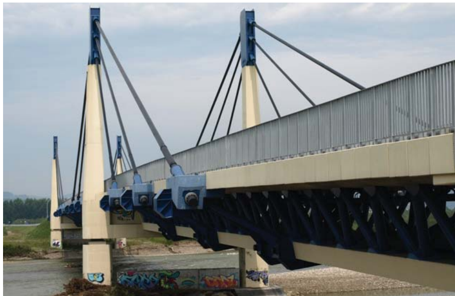
Most Św. Kingi w ciągu obwodnicy Starego Sącza
