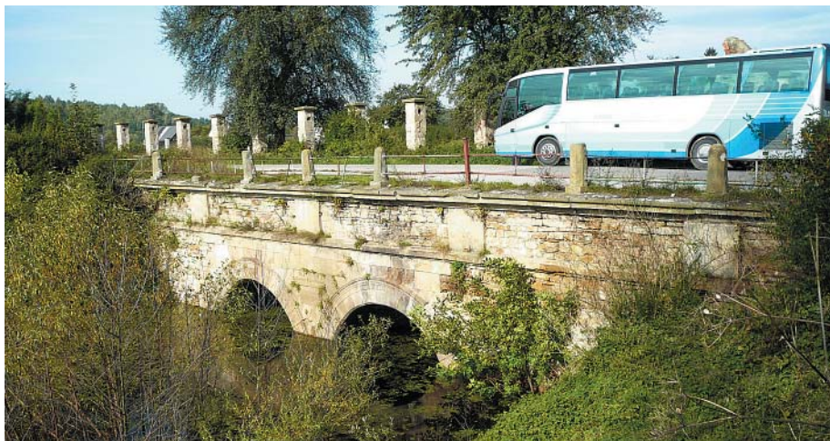
Most zabytkowy – element systemu kanałów doprowadzających wodę do Walcowni w Nietulisku
