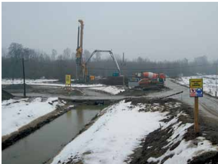
Plac budowy – betonowanie pala
