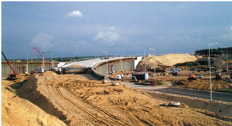
Teren budowy węzła autostradowego „Stryków”
