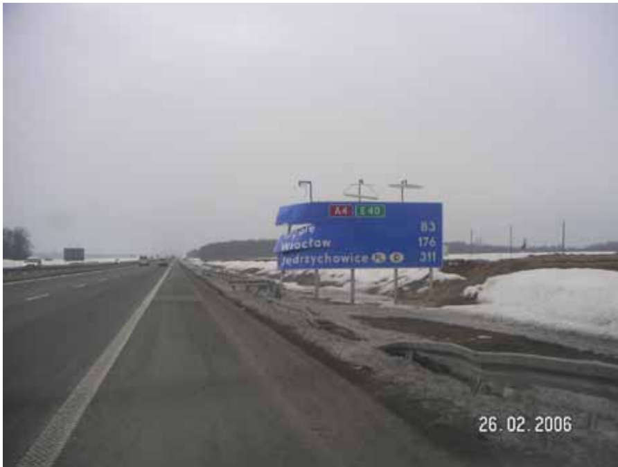
Fot. 3. Przypadek w którym bariera ochronna nie zabezpieczyła pojazdu przed kolizją z konstrukcją wsporcą tablicy drogowej
