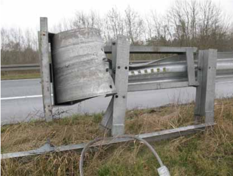
Fot. 7. Bezpieczne zakończenie bariery ochronnej po uderzeniu pojazdu - część energii zderzenia została zaabsorbowana przez specjalnie zaprojektowane elementy, przez co zdecydowanie zostały zmniejszone skutki wypadku
