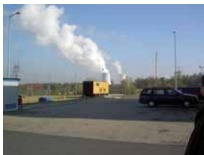
Fot. 12. Generator prądu
