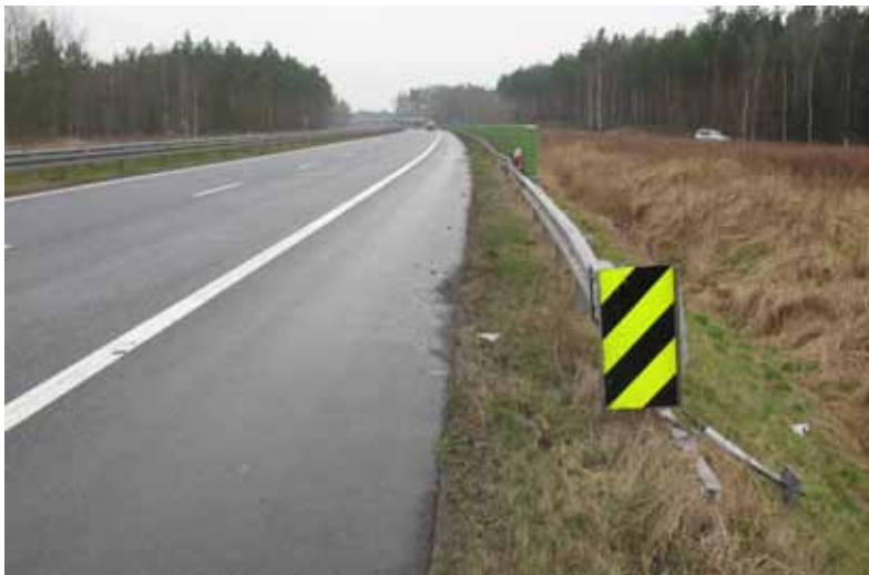
Fot. 8. Niewielkie zniszczenia urządzenia łatwo można zregenerować ponosząc nieznaczne koszty
