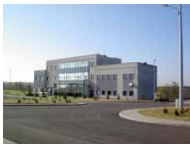
Fot. 15. Budynek CZA
