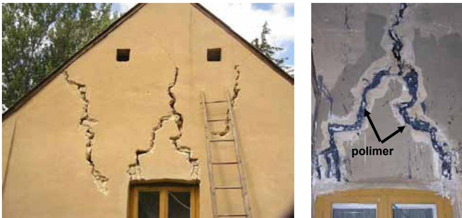
Rys. 3. Naprawa pękniętego budynku jednorodzinnego metodą złącza podatnego
