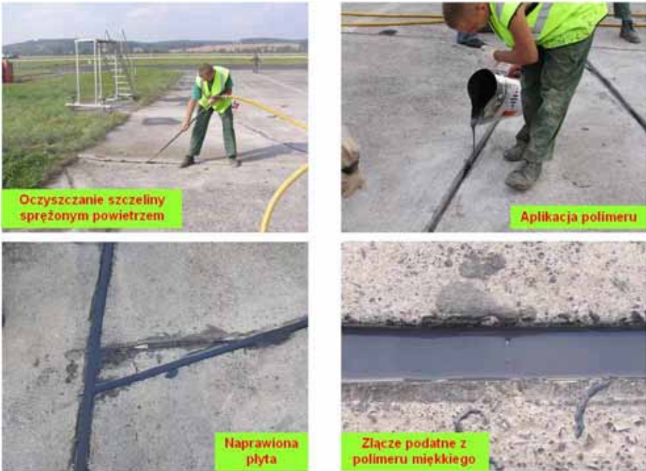
Rys. 6. Naprawa betonowej płyty lotniskowej przy użyciu polimerowego złącza podatnego [6]
