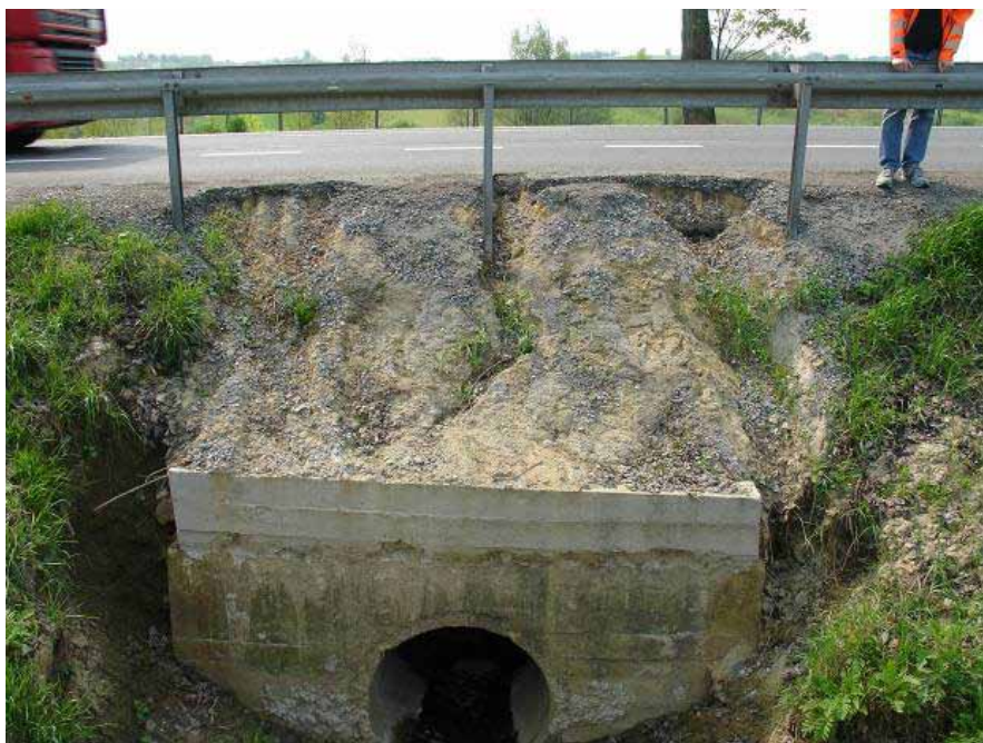
Fot. 15. Wykonanie skarpy nasypu drogi nad przepustem zgłoszone na odbiór techniczny
