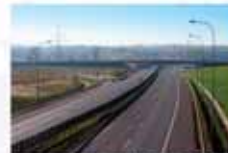
Autoroute A4, węzeł Kraków-Bezrzeczka, widok w kierunku Kraków- Rybnica Motorway A4, Kraków-Bezrzeczka road junction, view towards Kraków
