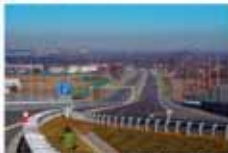
Pierwsza część drogi S7 widziana od węzła Kraków-Bezrzeczka w kierunku węzła Kraków-Rybnica The first completed portion of S7 road view from Kraków-Bezrzeczka road junction towards Kraków Railway road junction
