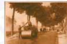
Widok drogią przy obwodnicy Bezrzeczka. Droga mostowa View of the road passing through Bezrzeczka. Bridge road passing through
