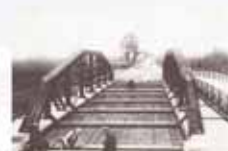
Most, konstrukcja stalowa z party obrotu Steel truss bridge with turn span
