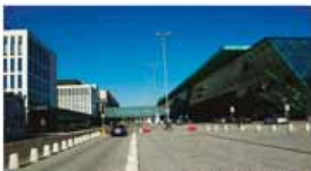
Składowisko Techniczne, Wielofunkcyjnego terminala lotniska w 2014 Construction of International Terminal of Kraków Airport in 2014
