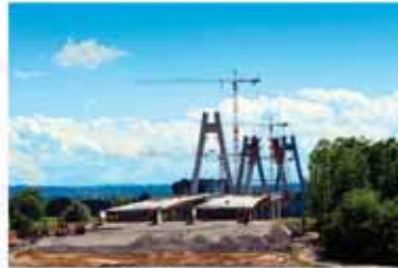
Most na Włocław w ciągu drogi S7 Bridge over the Włocław River along S7 road
