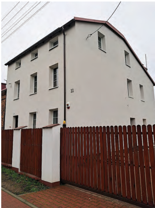
Siedziba Oddziału - efekt końcowy prac
