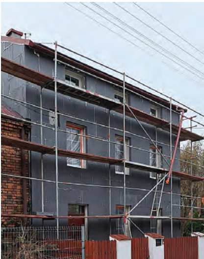
Prace docieplenia budynku
